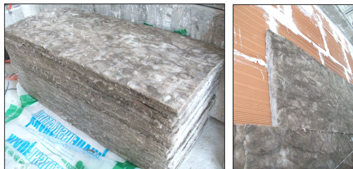
Imágenes 19 y 20 Lana mineral y su colocación
