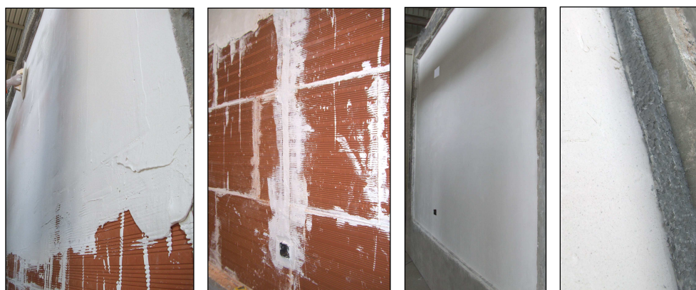
Imágenes 15, 16, 17 y 18 Enyesado y roza en la pared de Megabrick de 6 Hueco Doble
