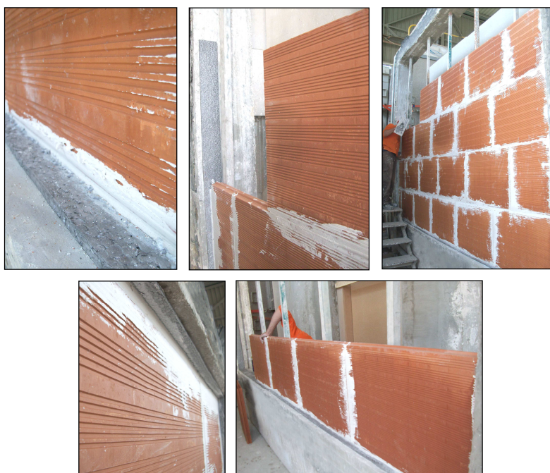
Imágenes 10, 11, 12, 13 y 14 Construcción de la pared de Megabrick de 6 Hueco Doble
