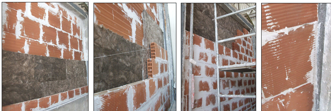
Imágenes 21, 22, 23 y 24 Construcción de la hoja de Megabrick Acústico Triple de 7
