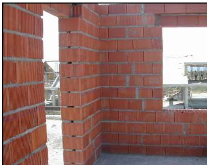
Empleando piezas medias y piezas de terminación
