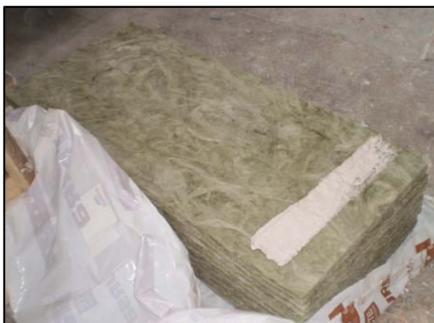
Aplicación de pelladas de pasta de montaje para instalación de la lana mineral
