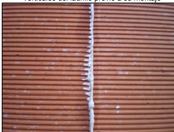
Junta entre piezas una vez montada el ladrillo
