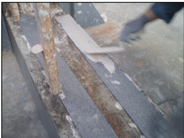
Bandas elásticas de EEPS en la base de las hojas de ladrillo de gran formato
