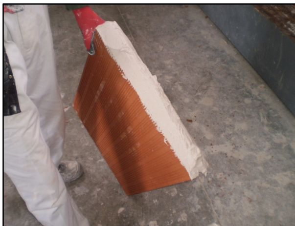
Aplicación de pasta de montaje en las llagas verticales del ladrillo previo a su montaje
