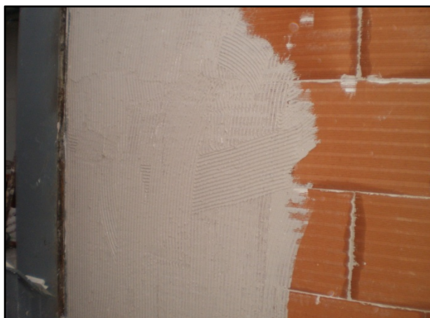
Aplicación de pasta de montaje cerámico sobre la hoja mediante llana dentada de 1 cm de diente
