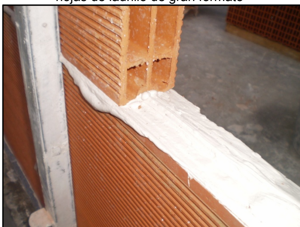
Detalle de montaje entre hiladas contrapeadas con aplicación de pasta en las llagas horizontales
